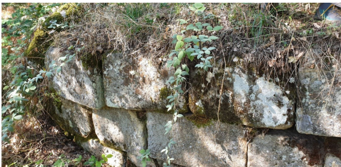
Muratura di cinta dell'acropoli al sito archeologico di Tempa Cortaglia
